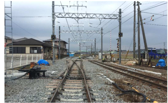
三岐線 保々駅構内重軌条化工事
