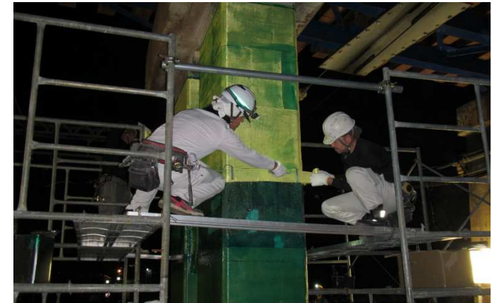
北勢線 名古屋線跨線橋橋脚補修工事
