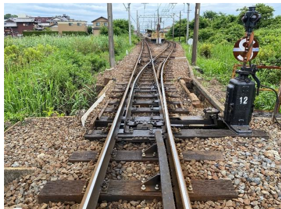
七和駅構内レール交換工事
