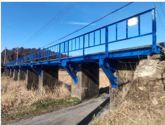
山田川橋梁塗装工事
