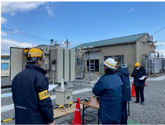
萱生変電所機器更新工事
