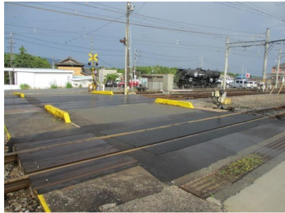
東藤原4号踏切道改修工事
